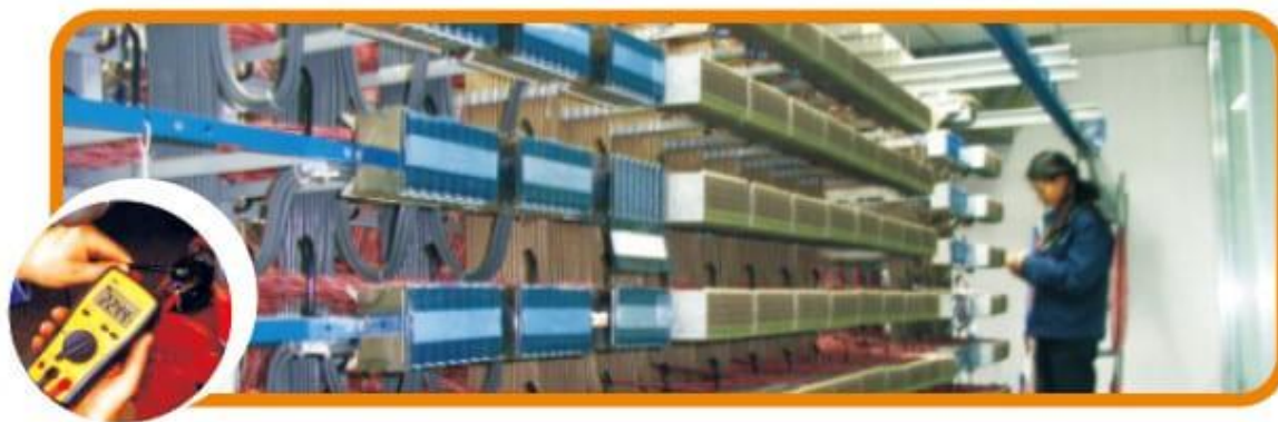
Jak najít rychle hledaný kabel? Použijte hledačku kabelů s hledací sondou se zapnutou zvukovou signalizací.
